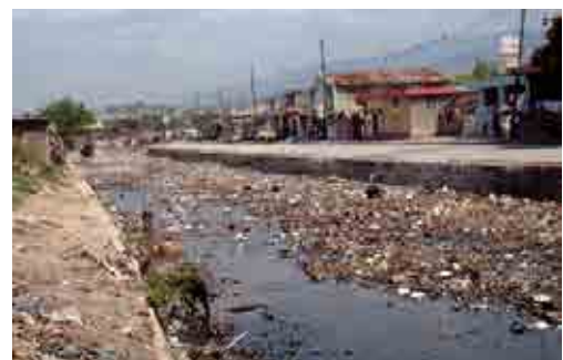
Offene Abwasserkanäle in den Armenvierteln von Uganda. Foto: Knopp. Quelle: www.welthungerhilfe.de
